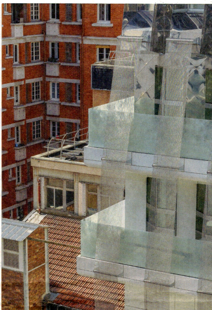
La nouvelle version du bâtiment de couleur blanche et bardée de métal tissé, se démarque de l'immeuble en brique en arrière-plan, où dominant la pierre, le zinc et les tuiles. [DR]
